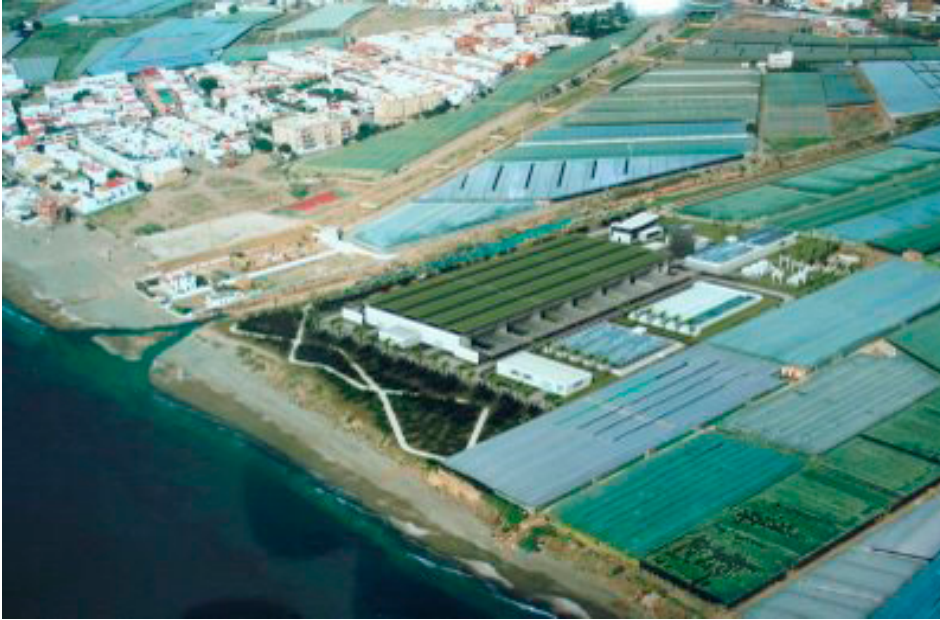
Fotografía 1. Desaladora. Campo de Dalías.
