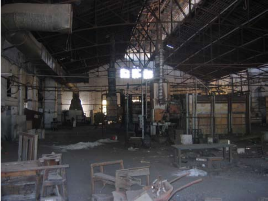
Fábrica de Vidrio La Trinidad de Sevilla.
