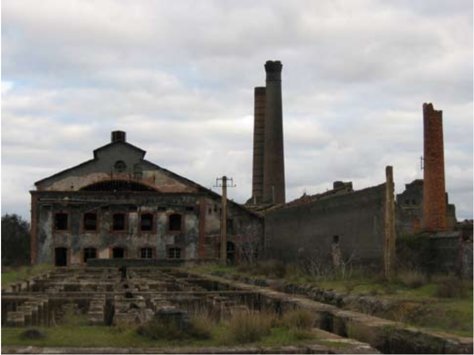
Central Térmica Cerco Industrial de Peñarroya (Córdoba).
