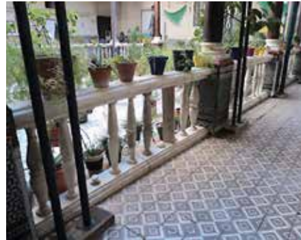
Figura 5.8.11 Balastrada del patio principal.
