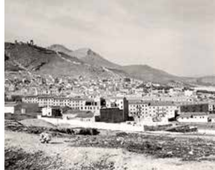
Figura 5.6.3 Las Protegidas en construcción.
