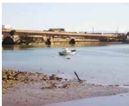
Figura 5.2.4 Puente Suazo. San Fernando.
