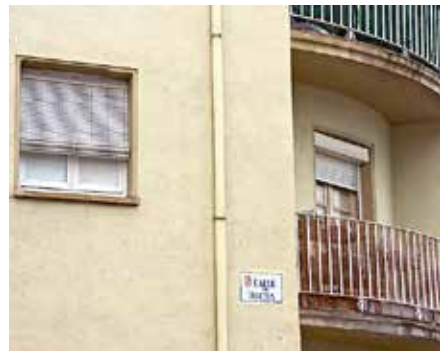
Figura 5.6.16 Balcón y ventana en calle Úbeda.
