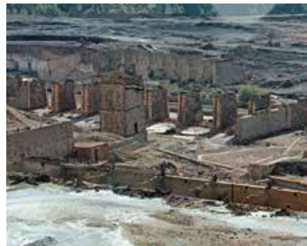
Figura 5.5.8 Instalaciones en desuso.
