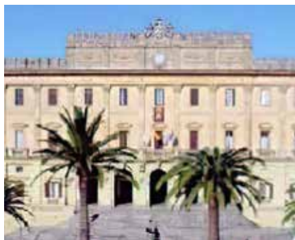
Figura 5.2.3 Ayuntamiento de San Fernando.
