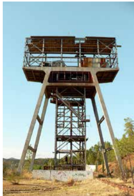
Figura 5.5.32 Acceso a Pozo Rotilio.
