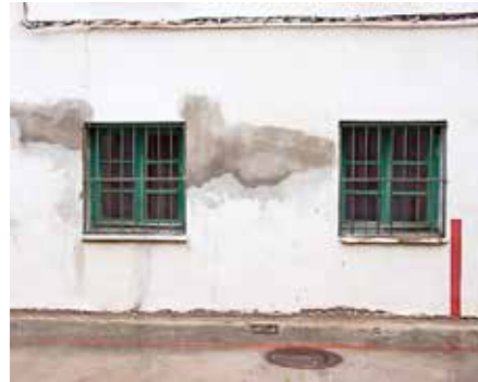
Figura 5.6.15 Ventanas a los patios interiores.
