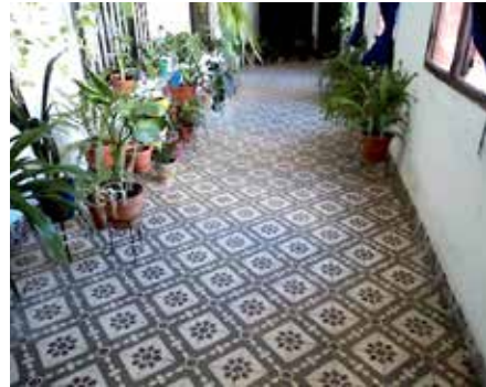
Figura 5.8.19 Solería hidráulica en galerías superiores.
