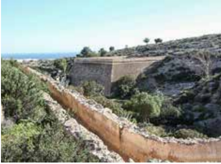
Figura 5.1.12 Balsa y acequia.
